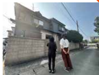
△ 外壁の仕上がりをチェック
