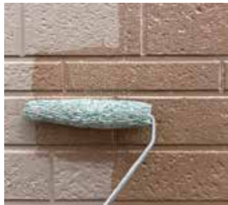
▲ 外壁 | 下塗りエポ・パワーシーラー
