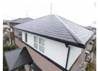
▲屋根と二階部分 | 塗装完了後
