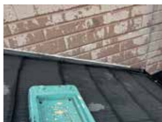
▲屋根 | 水試験(雨漏れ箇所特定試験)
