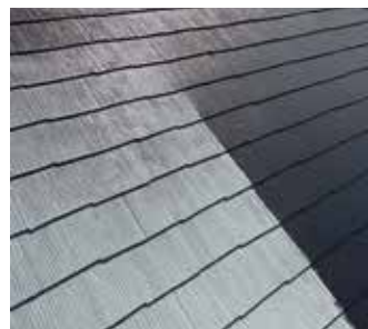
▲ 屋根 | 中塗りスーパーシャネツサーモF
