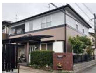
▲建物全体 | 塗装完了後
