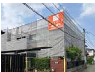
▲足場仮設 | 塗装前
