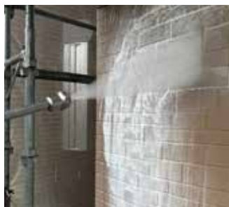
▲ 外壁 | バイオ洗浄
